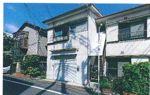
【S邸 施工前】 3棟 自宅・アパート2棟
